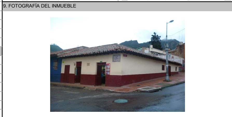
Fuente: Equipo Fotografía PEMP Patrimonio Inmueble
